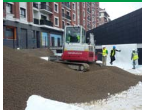
Reducción de cargas sobre estación de ferrocarril en Durango (Vizcaya).
