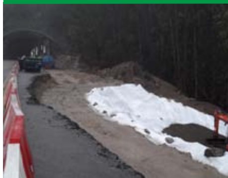
Núcleo de terraplén ligero sobre estructura enterrada en Corredor Do Morrazo (Pontevedra).
