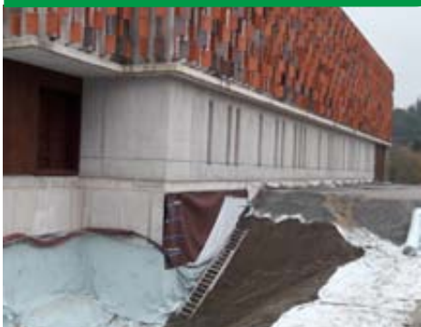
Reducción de asientos y empujes en urbanización junto al río Urumea (San Sebastián).
