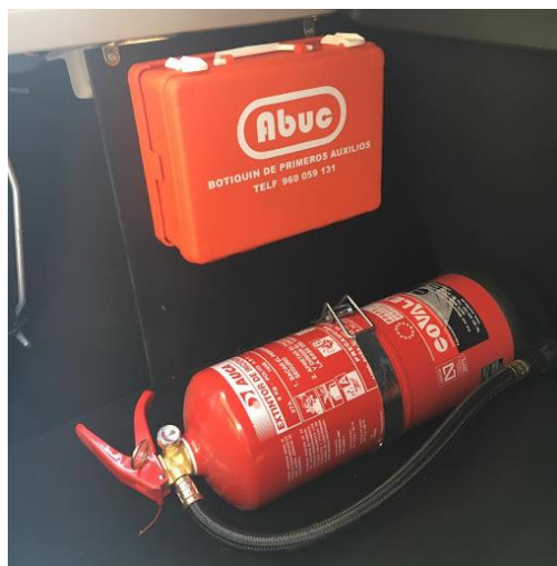
Figura 9. Extintor de incendios de polvo ABC y botiquín de primeros auxilios.
